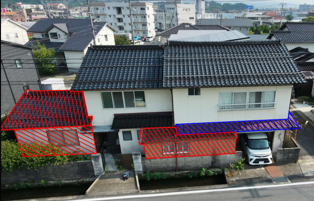
赤の部分は建物撤去を示す 青の部分は GL鋼板カバー工法葺き
