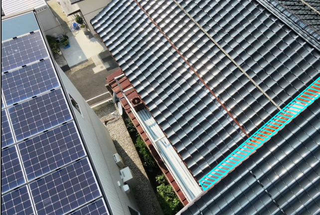
赤の部分は建物撤去を示す 青の部分は GL鋼板カバー工法葺き
